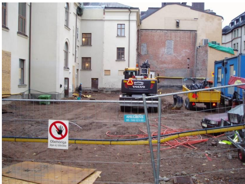
Figur 9. Den grovavjämnade ytan för grunden till hus B. Foto från nordost.
