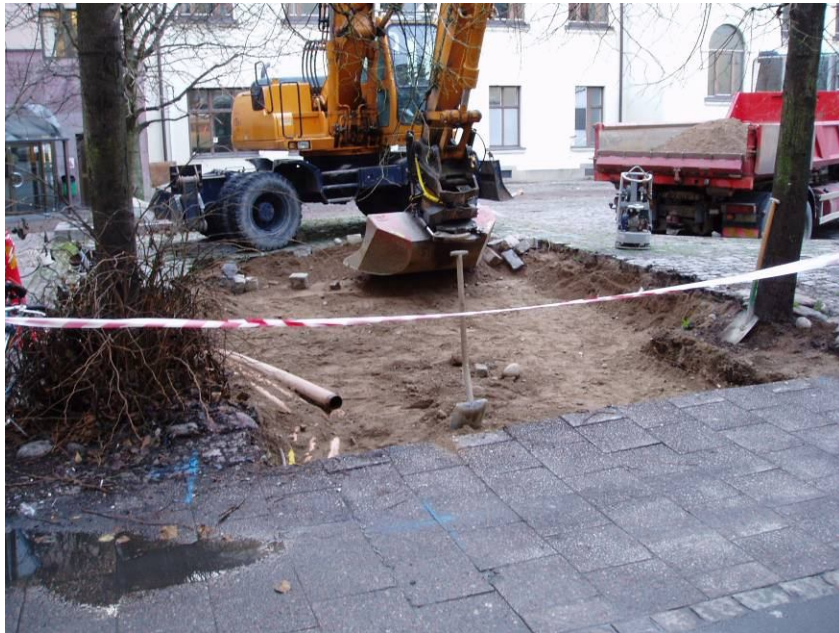
Figur 4. Schaktning påbörjad 26 november 2009 för transformatorstationen. Foto från nordväst.
