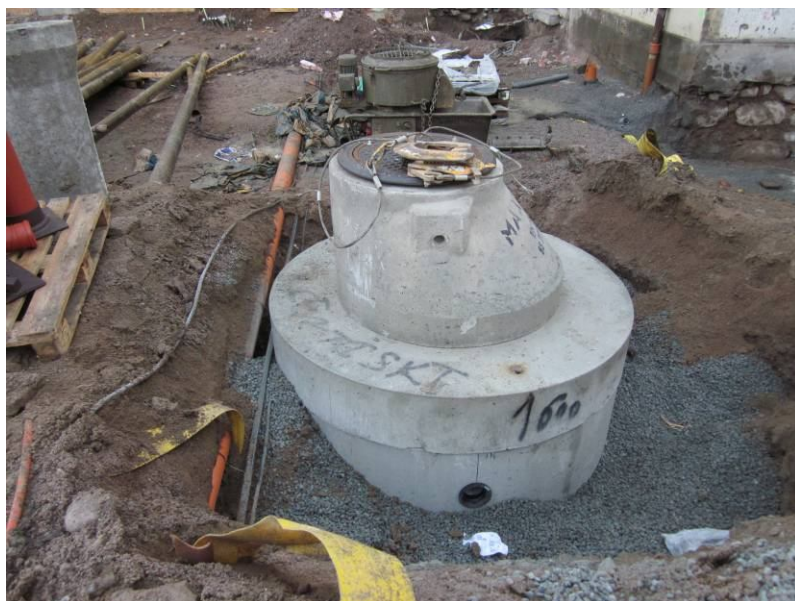
Figur 14. Fettavskiljarens placering inom den tidigare undersökta ytan. Foto från norr.
