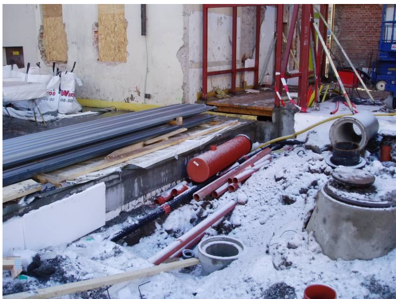
Figur 13. Den färdiga grunden till hus B anslutande mot hus C. Foto från norr.
