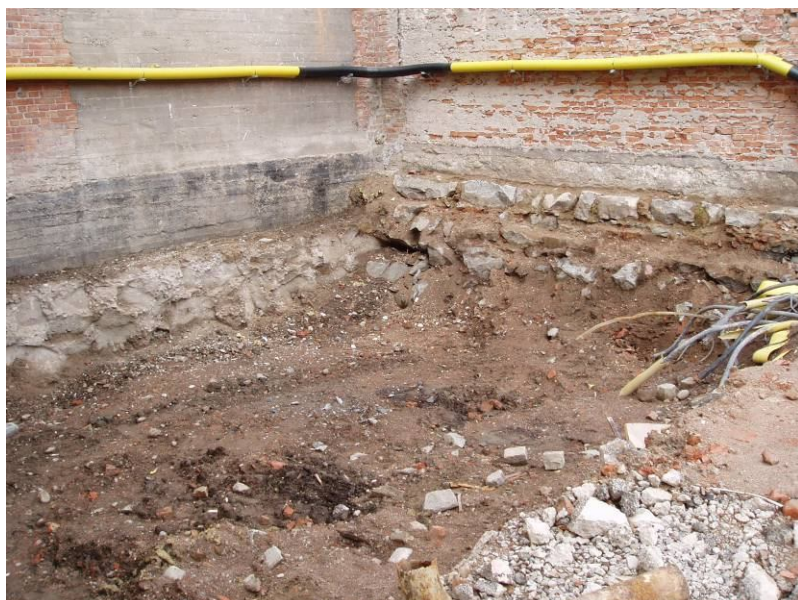
Figur 7. Schaktning gjord för grunden till hus C. Foto från öster.
