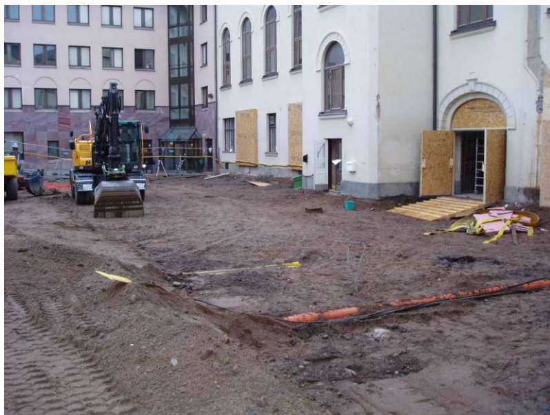
Figur 8. Grovavjämning gjord inför grundläggning av hus B. Foto från väster.
