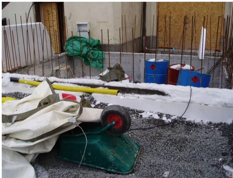
Figur 11. Gropen för rulltrappan, grundlagd och gjuten i januari 2011. Foto från nordväst.
