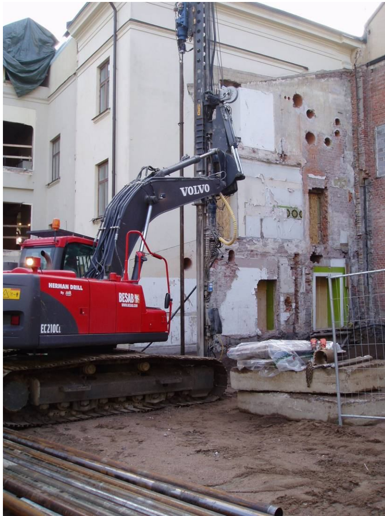
Figur 10. Pålingen med foderrör påbörjades i slutet av oktober 2010. I bakgrunden syns platsen för hus C. Foto från norr.
