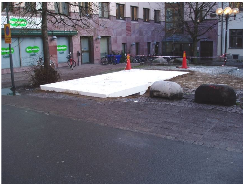
Figur 5. Schaktningen är avklarad och isolering har lagts ut på grunden. Foto från väster.
