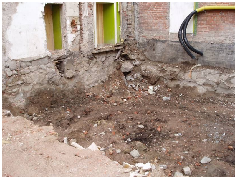
Figur 6. Schaktning gjord för grunden till hus C. Foto från norr.
