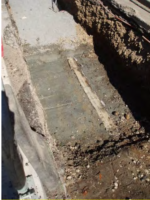
Figur 28. Nedgrävd i leran låg den huvudledning som mynnade ut i stadsdiket vid Vaksalatullen. Foto Bent Syse/Upplandsmuseet.
