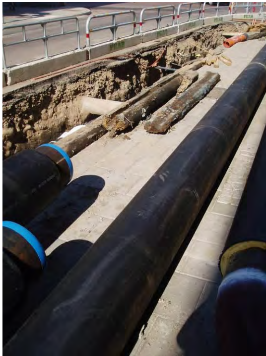
Figur 29. Över 300 år har gått mellan utvecklingen av de olika rören. Närmast i bild moderna isolerade rör för fjärrkyla. Strax där bakom borrade trästock för avlopp och längst bak orangea plaströr för avlopp. Foto Bent Syse/Upplandsmuseet.
