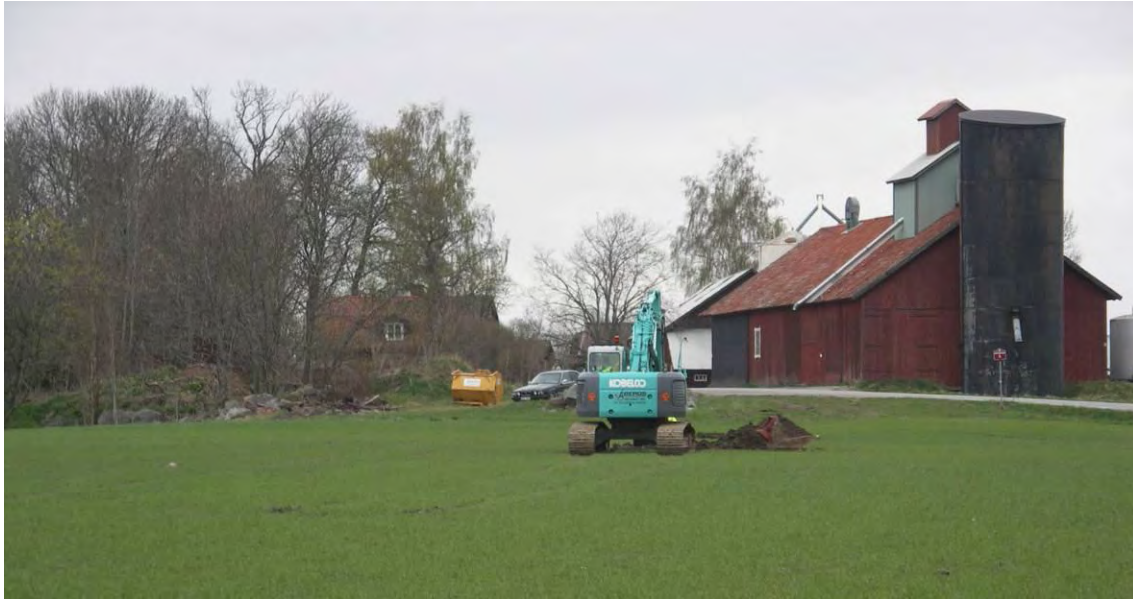
Figur 9. Schaktning vid Norrby; i fonden omkring och i den trädbevuxna dungen platsen för fornlämning Vaksala 299 och Vaksala 317. Foto (fr. SÖ): Per Frölund.
