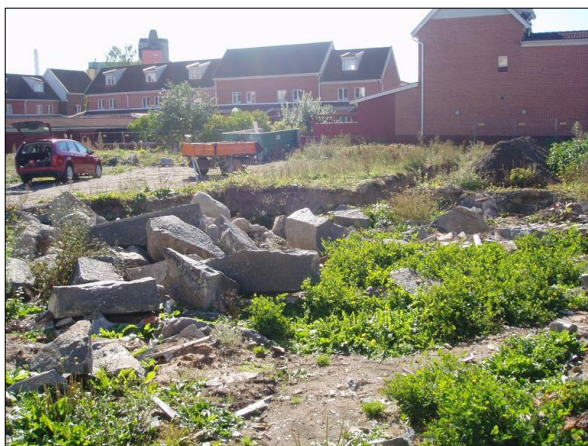
Figur 10. Undersökningsytan vid de inledande schaktningarna september 2007. Vy mot söder från korsningen mellan Eriksgatan och Sandgatan. I förgrunden syns den massiva störning som orsakats av en nu mera riven källare till hörnhuset på tomten. I bakgrunden avtecknar sig schakt 2, bortom gropen och i samma riktning som Eriksgatan. Foto: Bent Syse, Upplandsmuseet.
