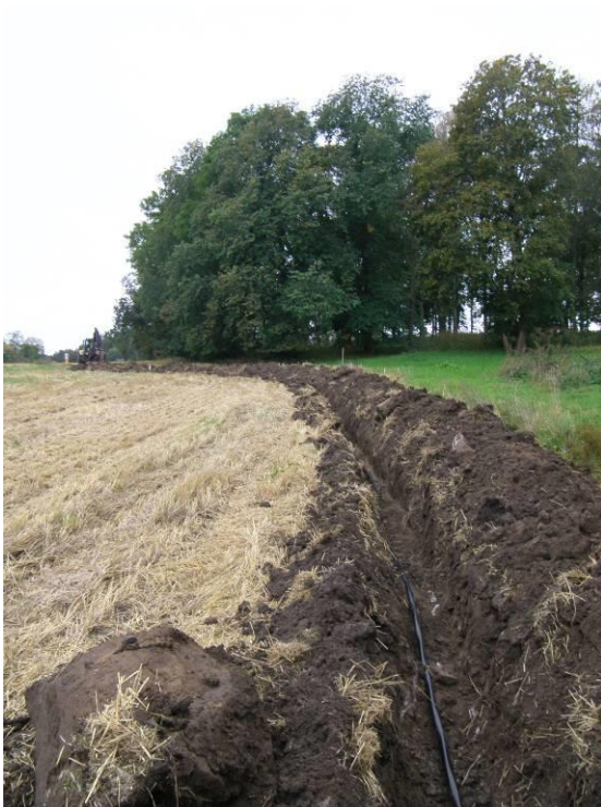
Figur 5. Schaktning inom område 2. Den närmaste delen av gravfältet nr 62 finns i dungen till höger om schaktet. Foto från norr mot söder.
