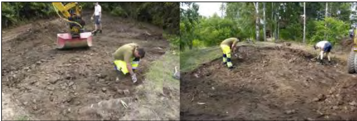
Figur 5. Schaktning påbörjad i den sydöstra delen. Foto: Per Frölund, Upplandsmuseet.
