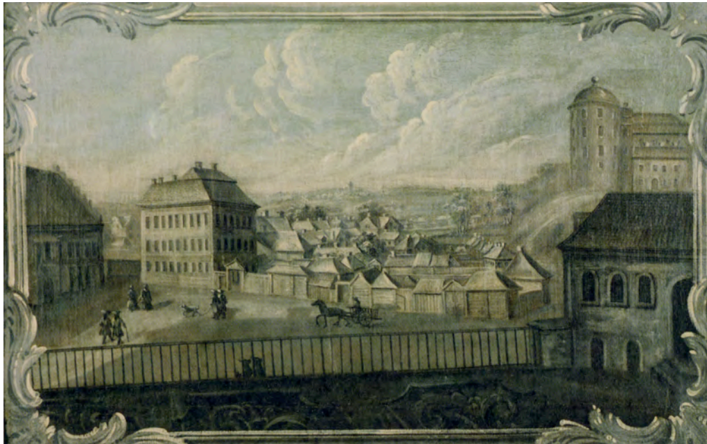
Figur 20. Oljemålning från 1700-talets mitt med utsikt över Riddartorget från Dekanhusets terrass (ur Harnesk 2006:77). Till vänster Skytteanum och Nosocomium Academicum. Notera byggnaden till höger som troligen är den byggnad som påträffades i schakt 3.
