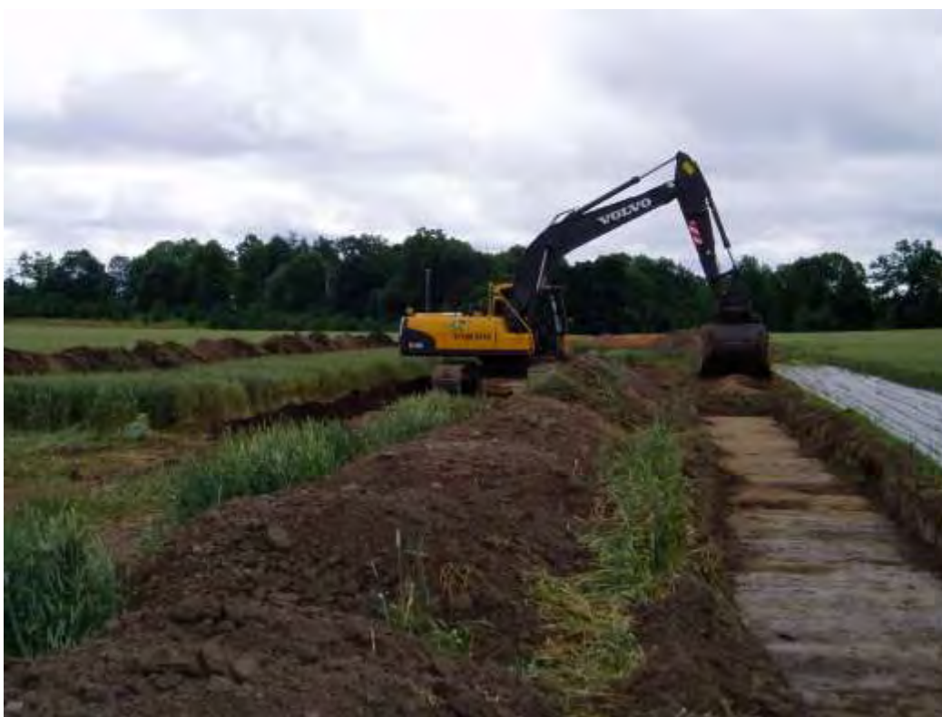
Figur 6. Schaktning på Område 1. Till höger i bild skymtar det tunna kulturlagret. Vy från norr. Foto: Malin Gustafsson, Upplandsmuseet.
