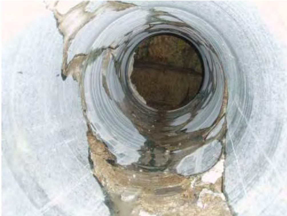
Figur 8. Foto in i borrhålet från utsidan som visar stenarna i grundmuren.
