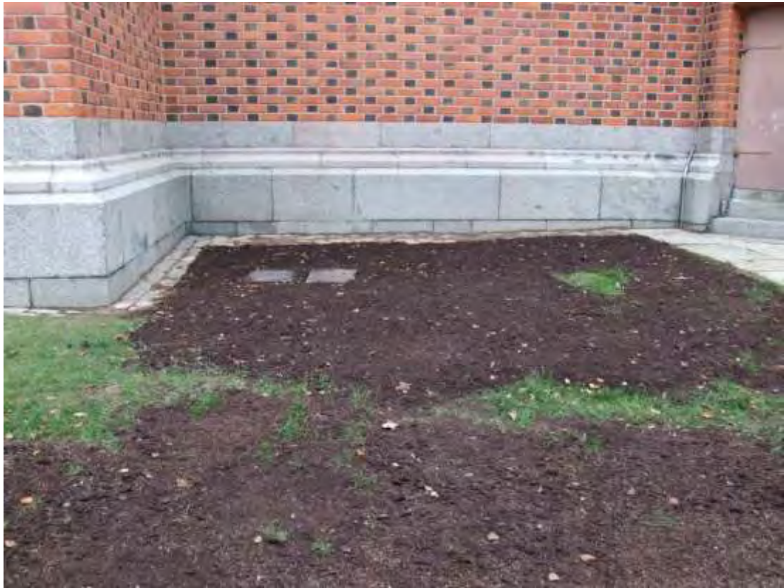
Figur 12. Platsen för radonbrunnen efter iordningsställande. Endast brunnslöcken till de två utblåsrören syns.
