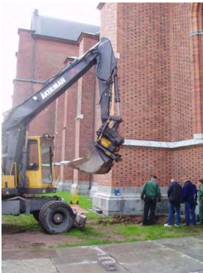
Figur 4. Schaktningen för radonbrunnen har precis startat på norra sidan om tornet.
