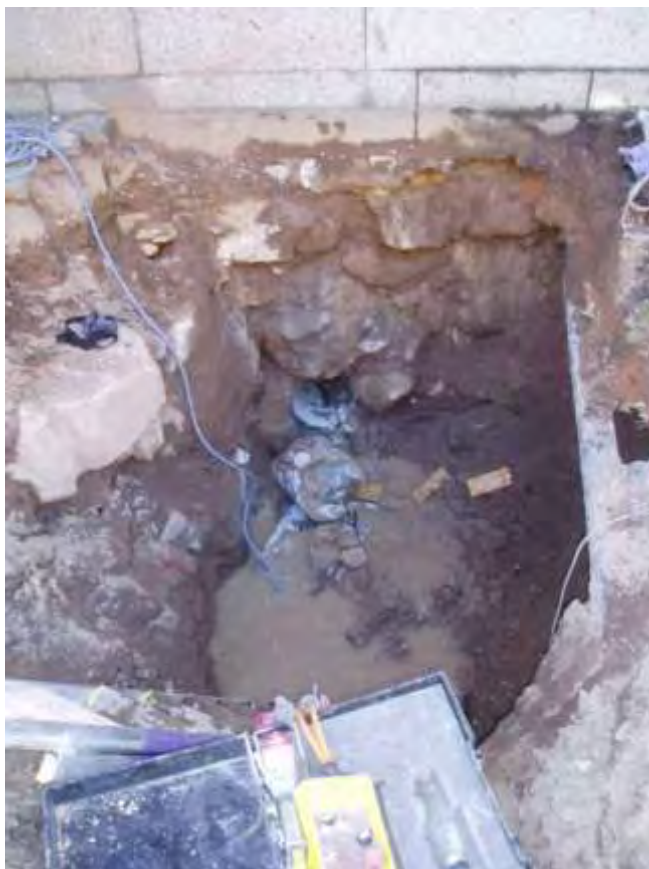
Figur 7. Borrningen är avslutad och en del av borkärnan ligger utanför hålet.
