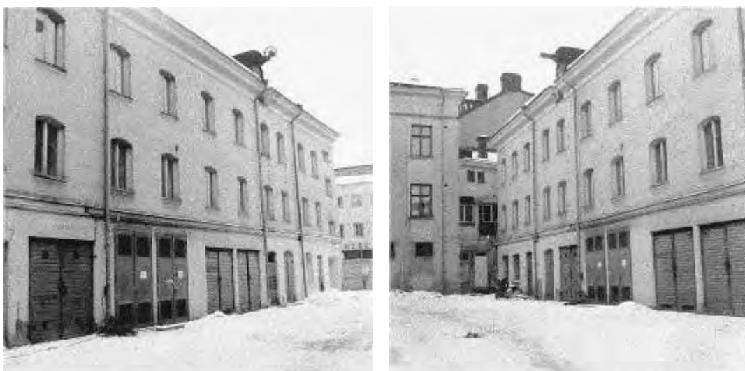
Figur 7. Foto av magasinsbyggnadens fasad på gården. Foto L. Gezelius 1977, Upplandsmuseet.
