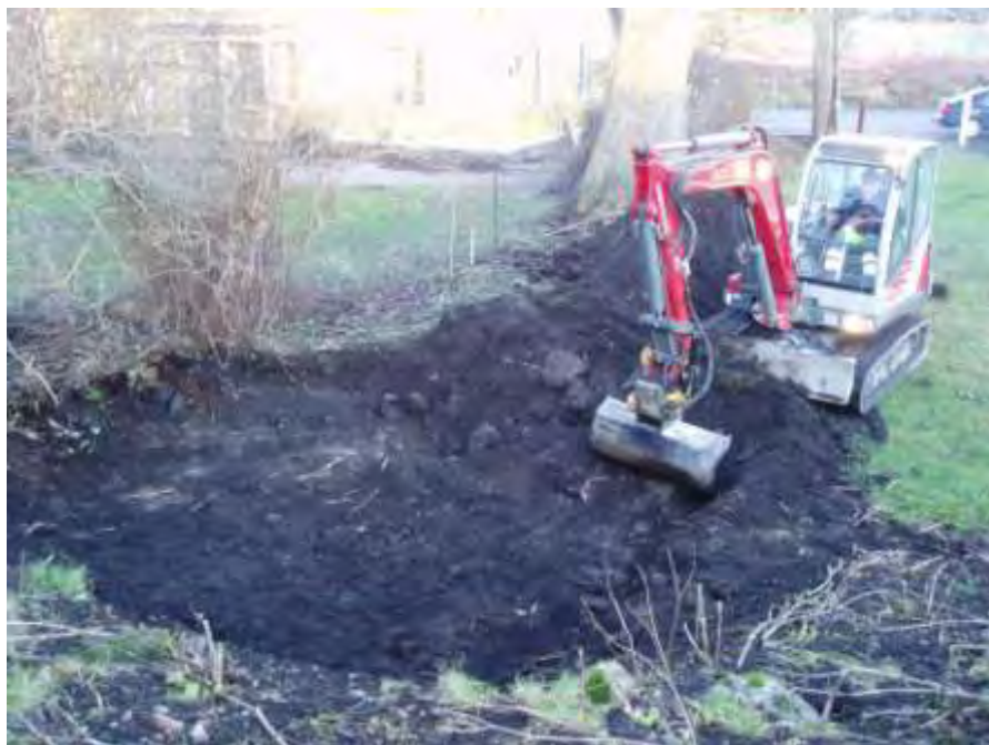
Figur 3. Schaktning för grundläggning av timmerlada (nr 2, fig 2). Foto från sydost.
