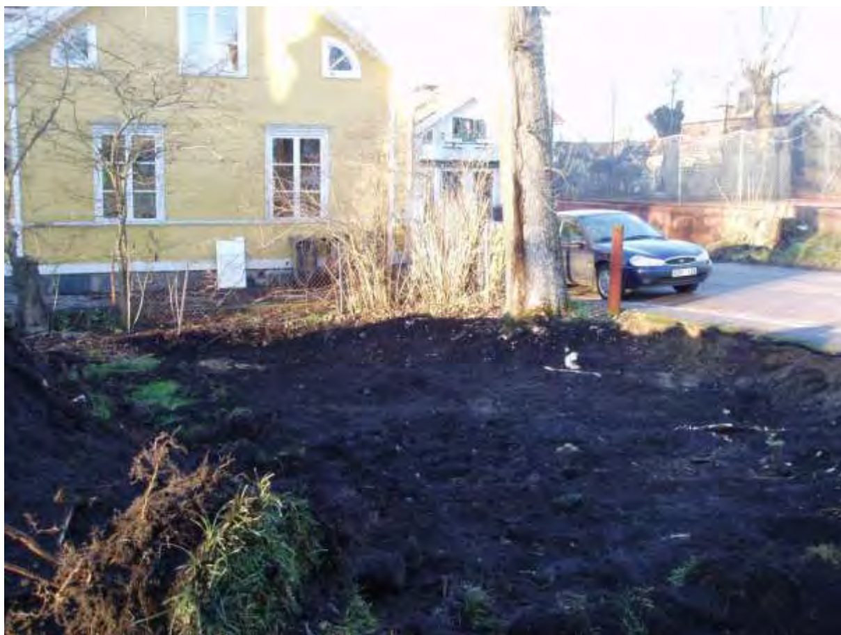
Figur 5. Schaktning för grundläggning av tröskladan (nr 3, fig 2). Foto från sydost.
