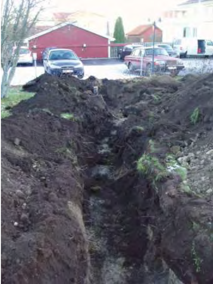
Figur 5. Foto av schaktet från punkt A mot nordost.
