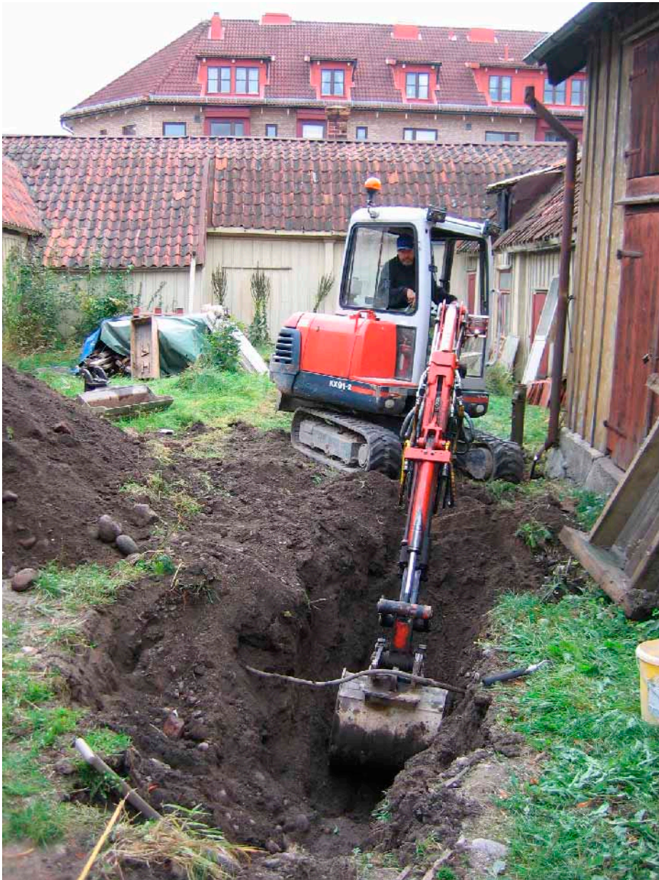
Figur 10. Kalle Billgren i minigrävaren påbörjar grävning i schakt 3. Foto mot söder.
