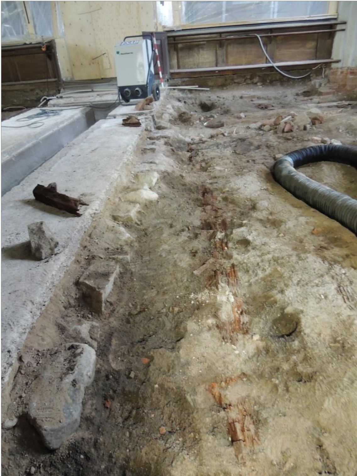
Figur 18. Sydöstra delen av långhuset i Jumkils kyrka, med rester av det äldre träbjälklaget synliga. I bakgrunden den tillfälliga avspärningen mot koret. Foto mot Ö, Elin Säll, Upplandsmuseet.
