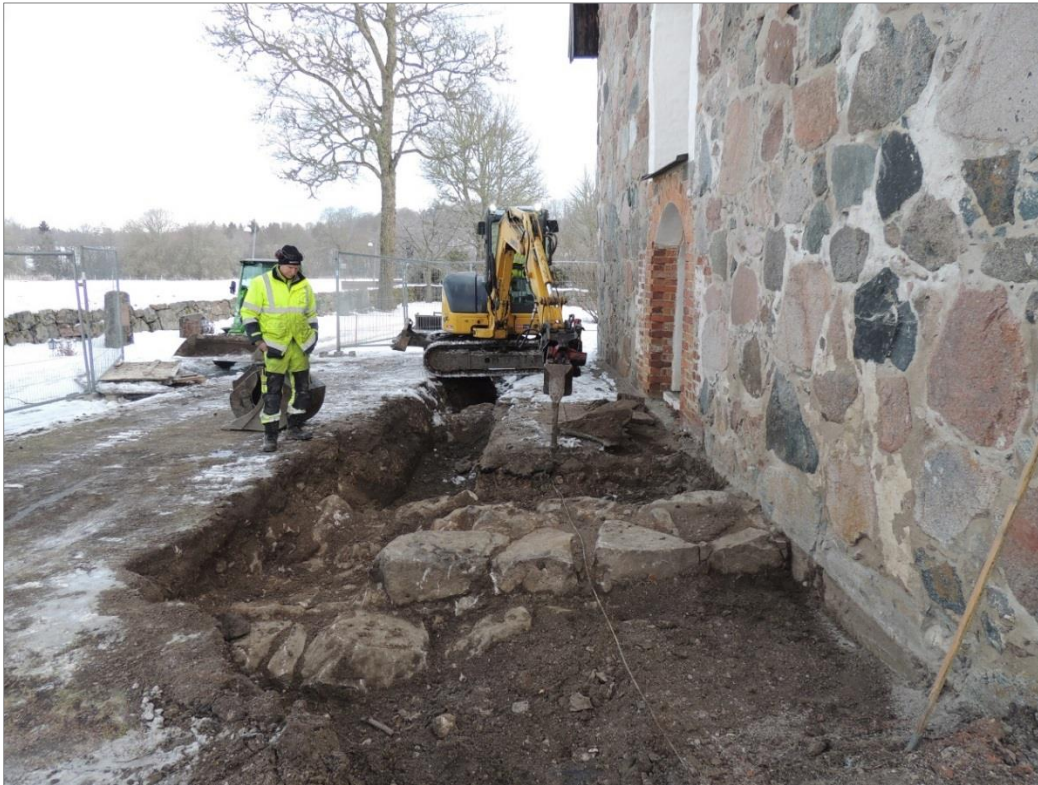
Figur 36. Västtornets södra mur. Foto mot N.
