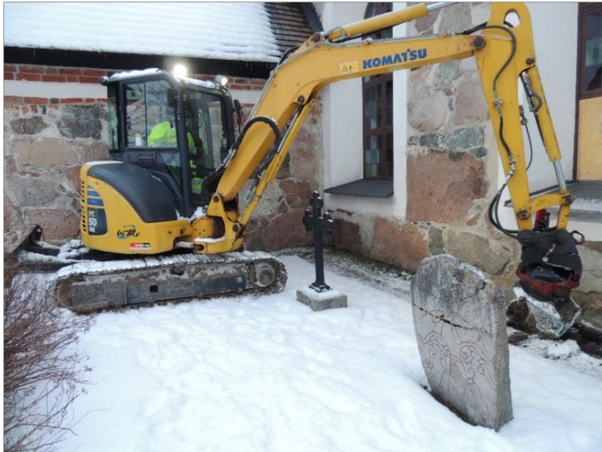
Figur 12. Schaktning invid kyrkans sydvägg. Foto mot NV.
