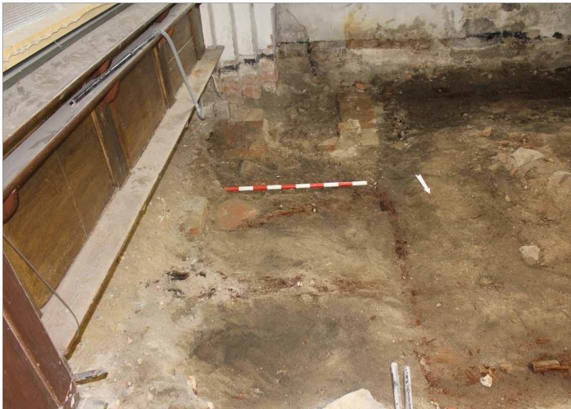
Figur 21. Korskranket synligt till höger om pelaren i kyrkans södra långvägg. Vy mot söder. Foto mot S, Elin Säll, Upplandsmuseet.
