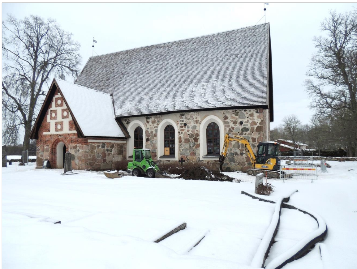
Figur 27. Schaktning invid kyrkans södra långsida. Termometern står på -18 grader och en grav (se nedan) har precis påträffats. Vy mot NV.
