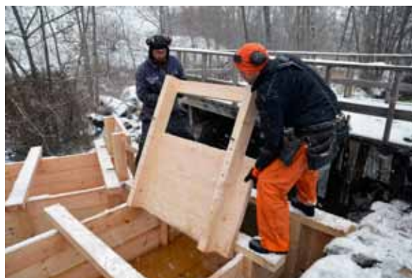
Timmermännen Márten Forsman och Per Olsson lyfter dammluckan och vattnet forsar åter i de återställda vattenrännorna inom byggnadsminnet Focksta kvarn i Hagby socken. Foto Agnetha Pettersson.
