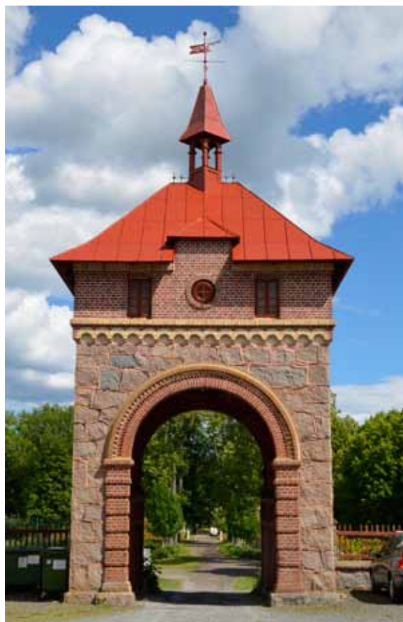
Ladugårdsanläggningen vid Örbyhus slott uppfördes 1874 efter ritningar signerade arkitekt Carl Granzow. Den var modern för sin tid och var bl.a. utrustad med vattenledningar. Portornet mot öster hade funktion som vattentorn, med en vattenreservoar ovanför portvalvet. Bilden visar portornet efter omläggning av plåttak och fönsterrenovering. Foto Agnetha Pettersson.
