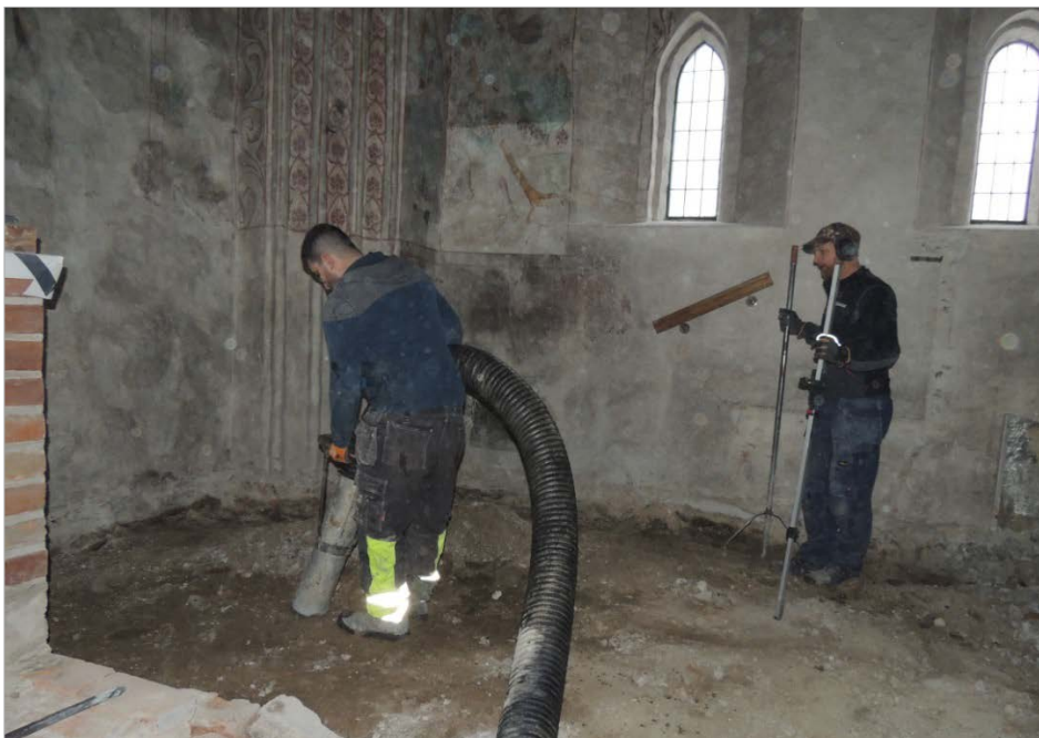
Figur 5. Massorna under betonggolvet förs ut med hjälp av torrsug.
