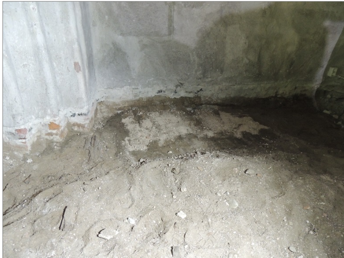
Figur 15. Ett område med kalkbruk längs den östra väggen. Till vänster om detta kan delar av den norra träkonstruktionen ses. Foto mot Ö.
