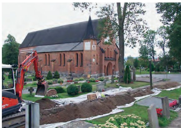
Arkeologisk övervakning för schaktning av bergvärmekulvert vid Mariakyrkan i Sigtuna. Foto Anna Ölund.
