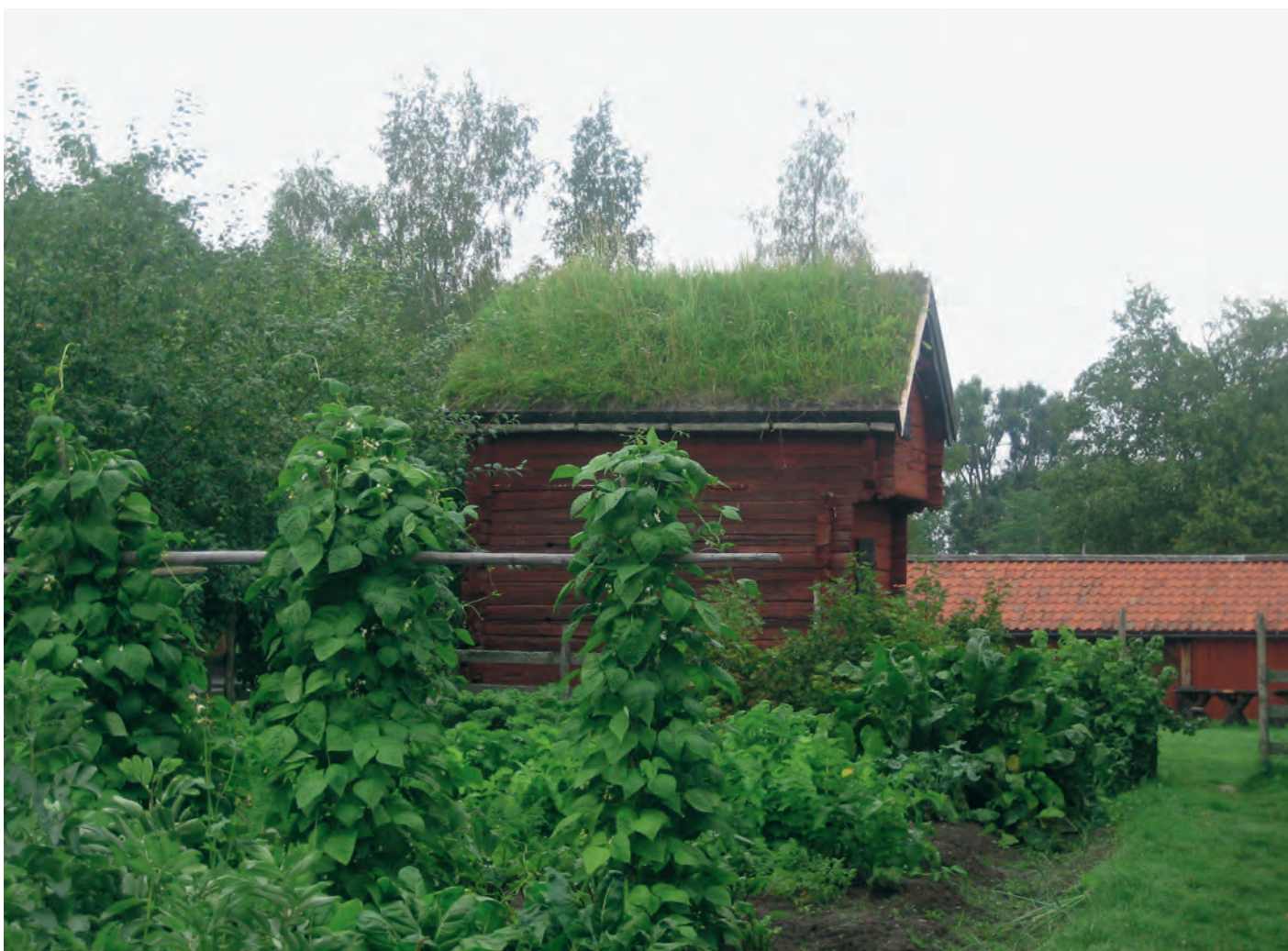
Ärentunaboden på Disagården med nylagt, grönskande torvtak. Foto Håkan Wallentinsson.
