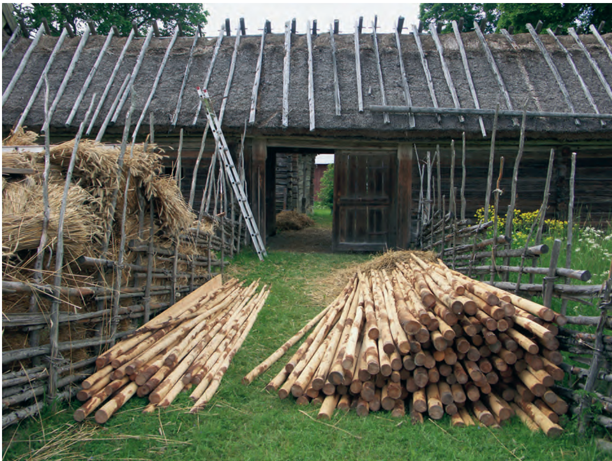
Långhalm av råg och tätvuxna grånstörar har levererats till Kvekgården för underhåll av taken. Foto Agnetha Pettersson.
