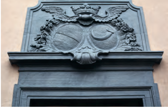
Överliggare och vapentavla på Salsta slotts portal efter avslutande linoljemålning. Foto Olle Norling.
