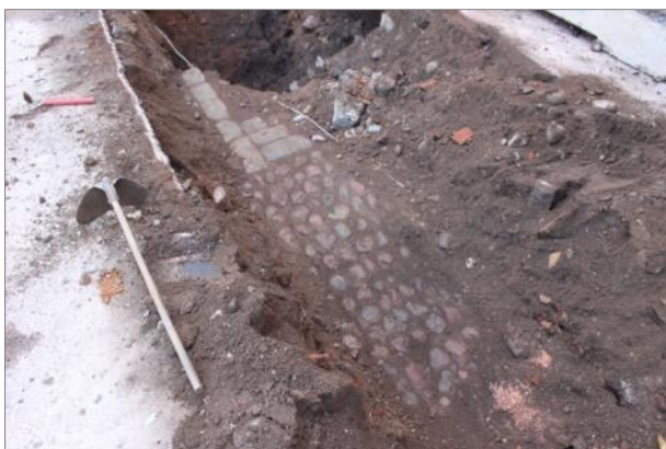
Figur 15. Stenläggningen 1a som legat på Gillbergska husets innergård fram till anläggandet av genomfarten 1935. Jämför med figur 6. Foto mot SÖ.
