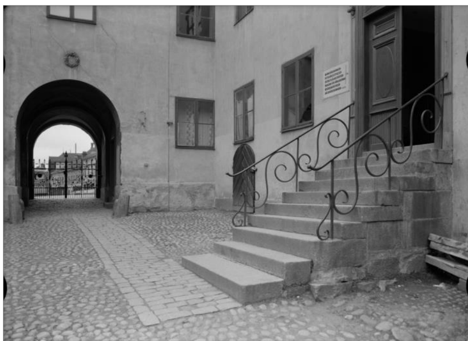
Figur 6. Innergården vid Gillbergska huset innan genomfarten byggdes. Foto från 1934, Paul Sandberg. Upplandsmuseets Bildarkiv (PS02862).
