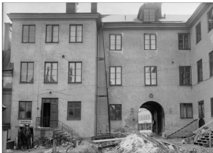
Figur 8. Pågående arbete på Gillbergska husets innergård. Foto från 1935, Paul Sandberg. Upplandsmuseets Bildarkiv (PS 02610).
