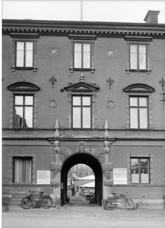
Figur 7. Pågående arbete med anläggandet av genomfarten. Bilden är tagen från Fyristorg och genom Gillbergska husets portal syns byggnadsarbetare i full fart med arbetet. Foto från 1935, Paul Sandberg, Upplandsmuseets Bildarkiv (PS02609).
