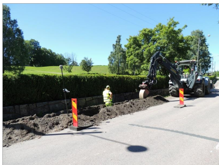
Figur 23. Schaktning längs Ärnävägen. Centralt i bild södra Kungsgårdsplatån. Vy mot väster. Foto: Robin Lucas, Upplandsmuseet.
