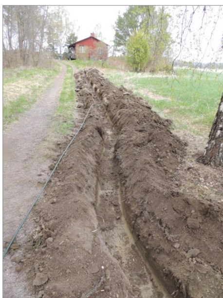
Figur 10. Delsträcka 3 under schaktning. Vy mot norr. Foto: Robin Lucas, Upplandsmuseet.
