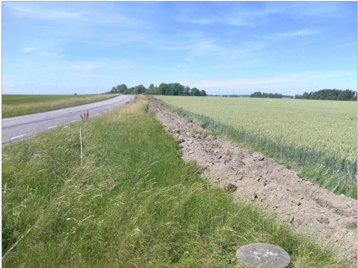
Figur 5. Delsträcka 1. Schakt upp mot den mindre höjden, som kan ses i horisonten. Vy mot nordväst. Foto: Hans Göthberg, Upplandsmuseet.
