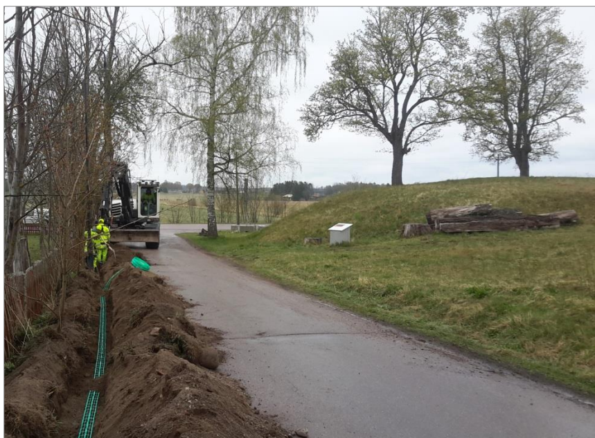
Figur 21. Schaktning längs Disavägen. Till höger i bild norra Kungsgårdsplatån. Vy mot norr. Foto: Robin Lucas, Upplandsmuseet.
