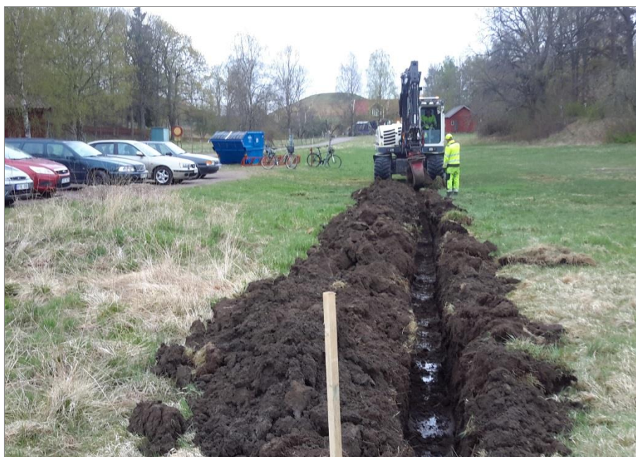
Figur 19. Schaktning från Ärnavägen till fastigheten Gamla Uppsala 74:11. Notera hur vatten trängt upp i schaktets botten. Till vänster i bild Disagårdens parkering, i horisonten Högåsen med Västhögen. Vy mot söder. Foto: Robin Lucas, Upplandsmuseet.
