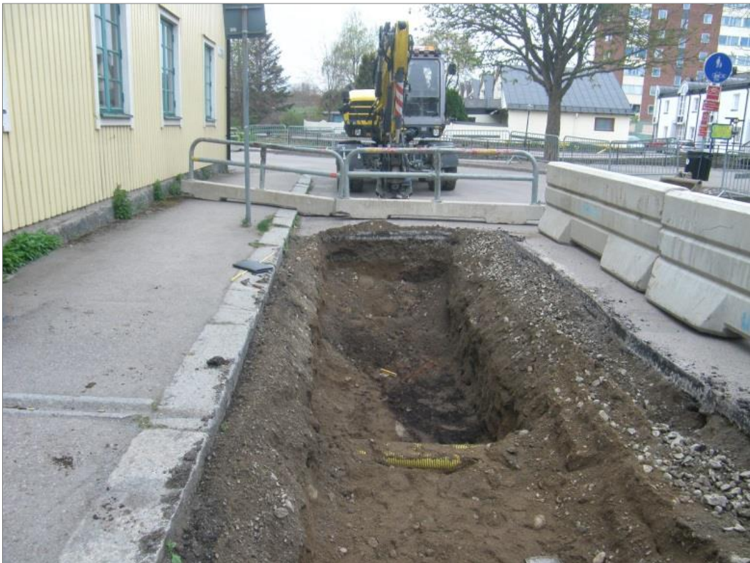
Figur 4. Schaktet i Eriksgatan, kv. Hovlagaren. Foto mot sydväst, Malin Lucas, Upplandsmuseet.
