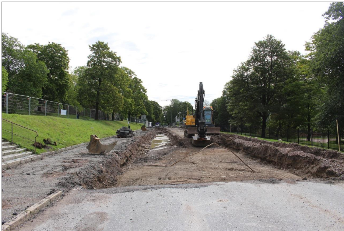
Figur 8. Pågående schaktning av Dag Hammarskjölds väg. Foto mot S.
