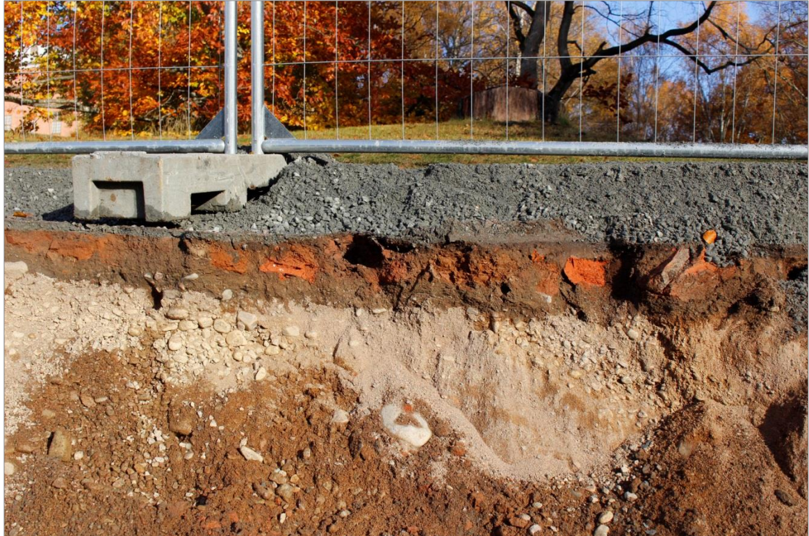
Figur 23. Detaljbild på tegellagningen som låg ca 0,05.0,1 m under nuvarande gång- och cykelväg. Foto mot Ö.
