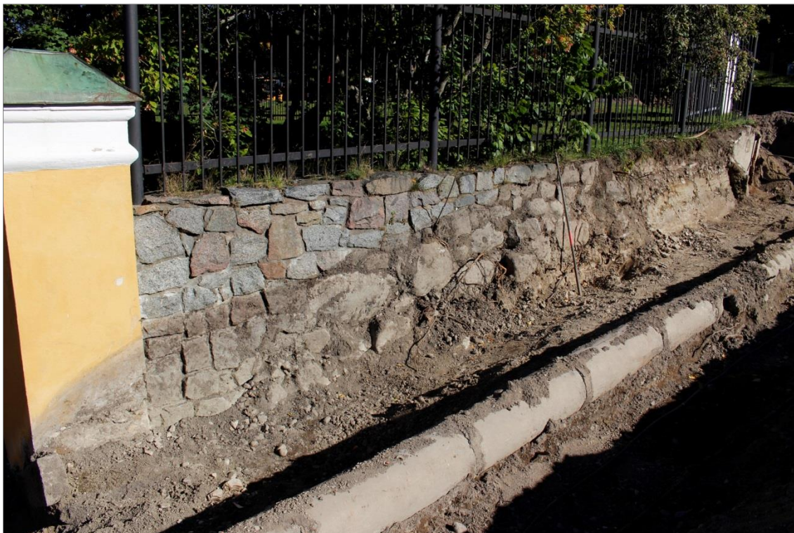
Figur 18. Den frilagda gråstensmuren till Botaniska trädgården. De undre delarna av denna utgörs av en äldre gråstensmur vilken syns centralt i bilden. Foto mot NÖ.
