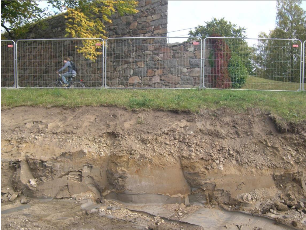
Figur 20. I den södra delen av arbetsområdet schaktades delvis även in i den östra terrassen. Liksom i den väster om Dag Hammarskjölds väg har denna anlagts genom att grus och sand påförts ovan den naturliga leran. Foto mot Ö.
