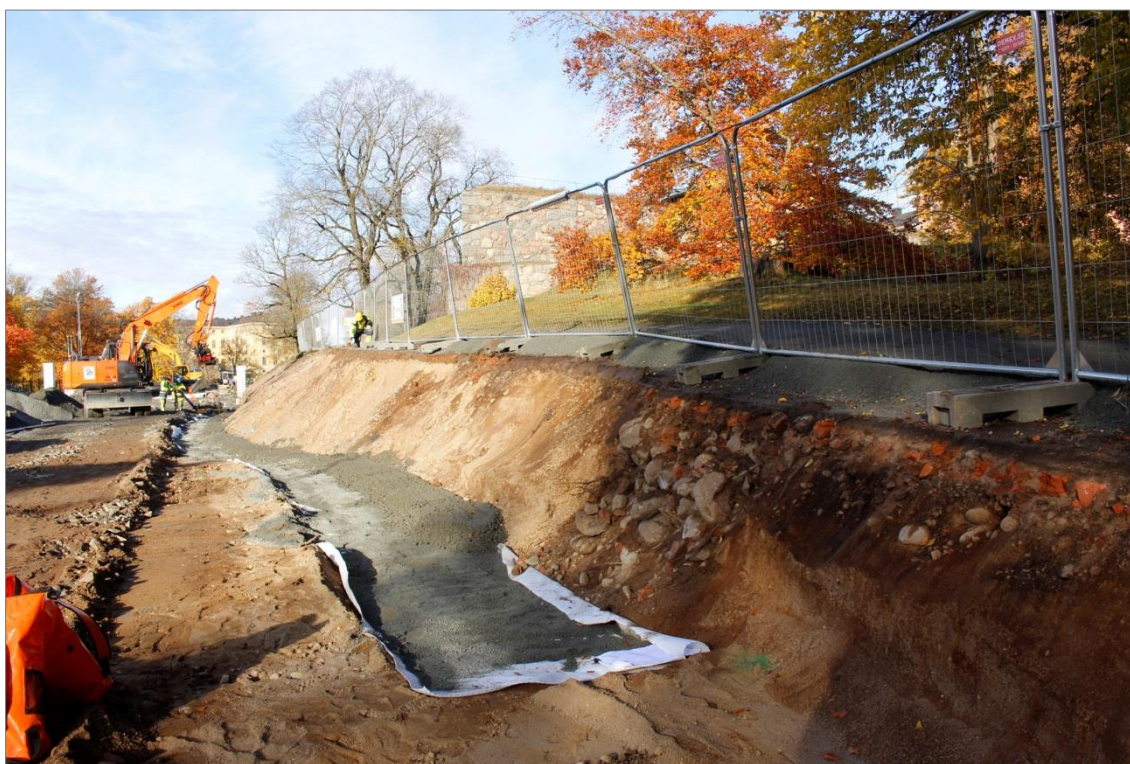
Figur 22. Den södra delen av arbetsområdet där delar av slänten nedanför bastion Gräsgården grävdes bort. Till höger i bild syns både tegelläggningen och nedgrävningen. Foto mot N.
