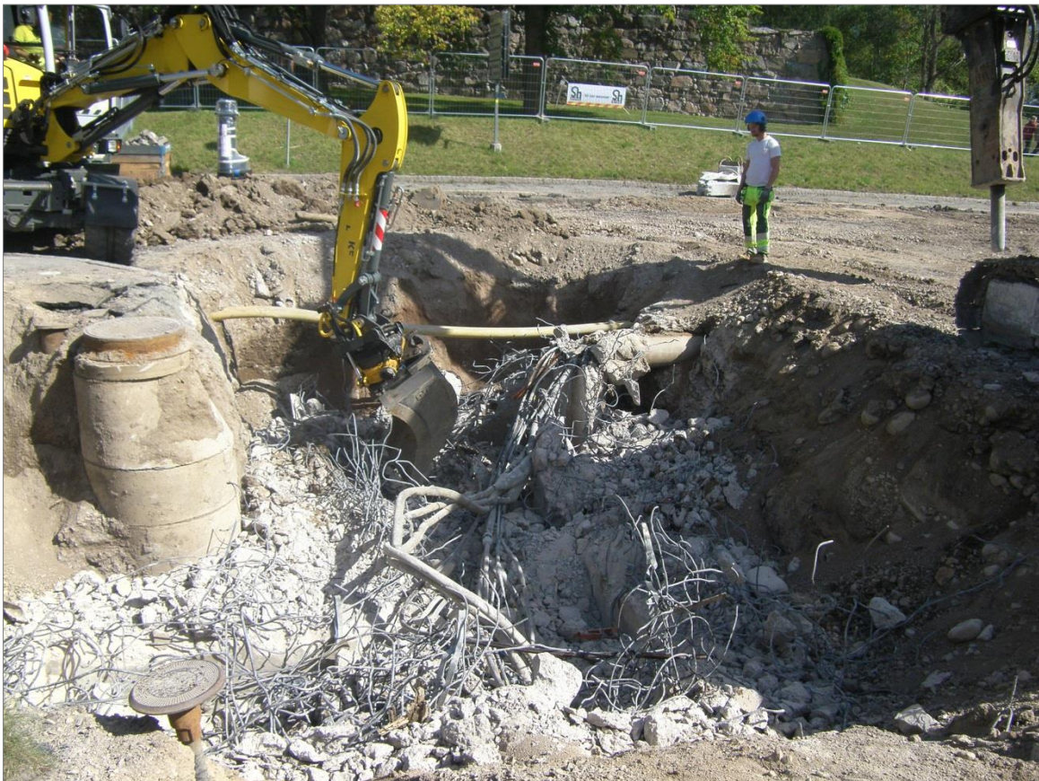
Figur 6. Flertalet ledningar och brunnar var sedan tidigare nedgrävda inom arbetsområdet. Här schaktas för byte av befintlig brunn vid korsningen Dag Hammarskjölds väg – Norbyvägen. Foto mot Ö. Anna Ölund, Upplandsmuseet.
