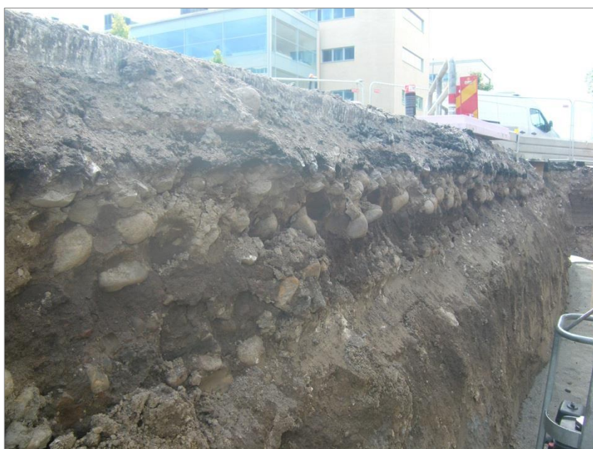
Figur 13. Detaljbild på stenläggningen som påträffades i Norbyvägen. Sannolikt är den en rest av en äldre vägbeläggning. Foto mot V. Anna Ölund, Upplandsmuseet.
