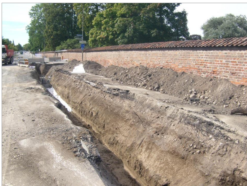
Figur 12. Schakt för byte av ledningar grävdes längs Norbyvägen. I den norra schaktkanten fanns rester av en stenläggning. Foto mot NV. Anna Ölund, Upplandsmuseet.
