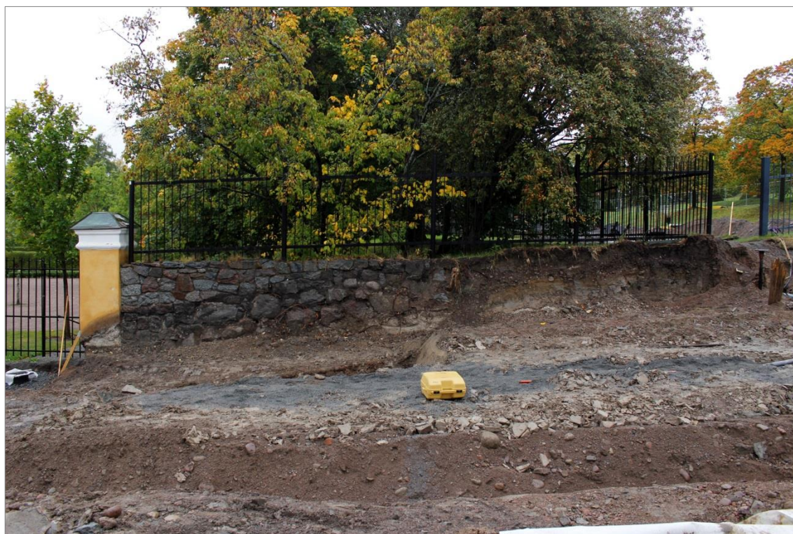
Figur 17. Vid schaktningsarbetet frilades den östra delen av Botaniska trädgårdens södra mur som visade sig utgöras av två generationer. I öst anslöt den även en av terrasserna. Foto mot N.
