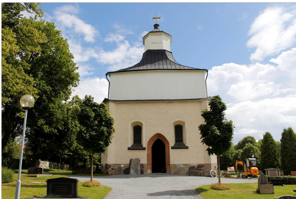
Figur 5. Pågående schaktningsarbeten vid Svinnegarns kyrka. Foto mot Ö.
