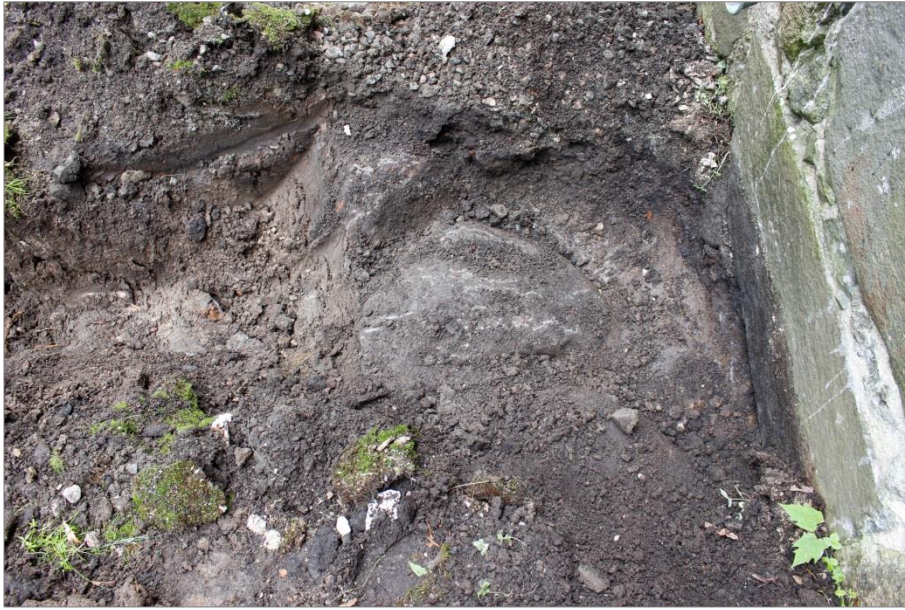
Figur 8. Vid kyrkobyggnadens norra långsida framkom i schaktet delar av dess grundmur (B).
