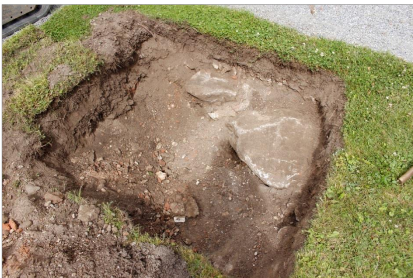
Figur 10. Söder om långhuset grävdes ett schakt för ny jordplåt. Här fanns två större stenar i den norra delen av schaktet. Möjligtvis kan de vara rester efter det medeltida vapenhusets grundmurar. Foto mot N.
