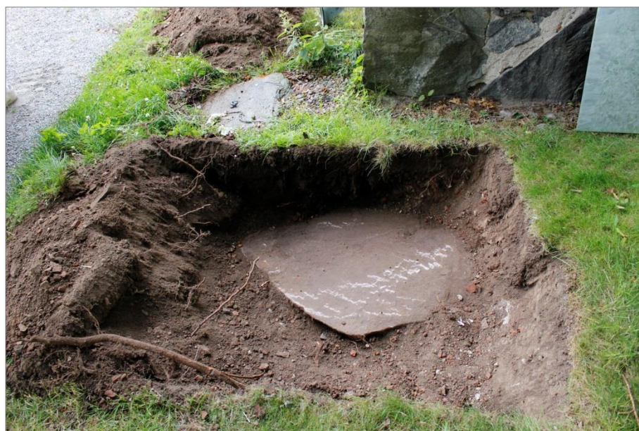
Figur 7. I schaktet vid sakristians norra sida påträffades ett stenblock. Då stenen fortsatte in mot sakristian, möjligtvis även in under sakristians grundmur, beslutades att lämna kvar den på plats och istället lägga jordplåten på östra sidan om sakristian. Foto mot S.
