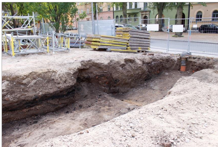
Figur 32. Den sydvästra delen av Sektion 1. Foto mot S.
