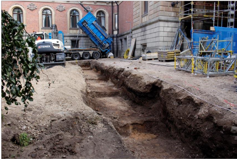
Figur 30. Schakt A grävdes för montering av stödmur. Schaktet förlades i nordöstlig-sydvästlig riktnig. En sektionsritning upprättades för den sydöstra schaktväggen. Foto mot NÖ.
