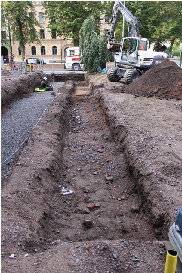
Figur 43. Översikt över Schakt B som grävdes parallellt med Schakt A. Foto mot SV.
