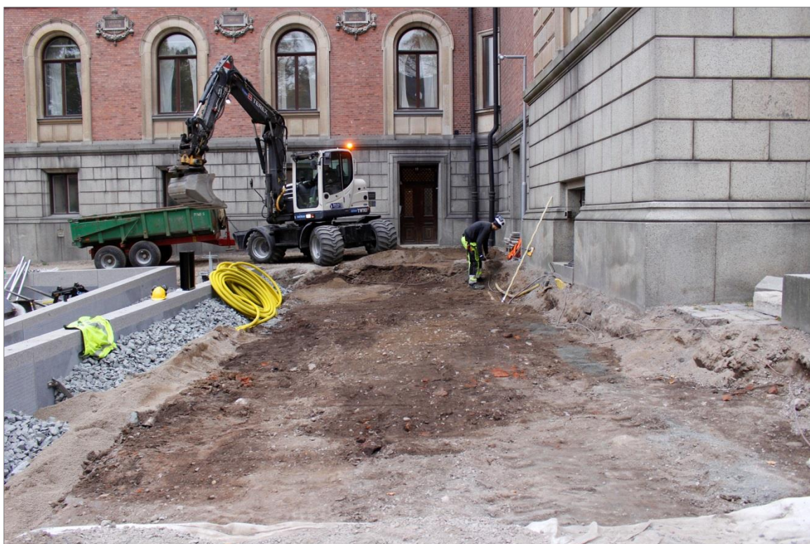
Figur 23. Pågående schaktningsarbeten vid Universitetshuset i oktober 2016. Foto mot NÖ.
