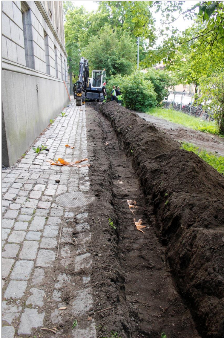
Figur 3, bilaga 5. Radonrörsschaktet på Universitetshusets norra sida, som löpte i befintligt schakt för teleledning och åskskyddsledning. Foto mot V, Anna Ölund, Upplandsmuseet.
