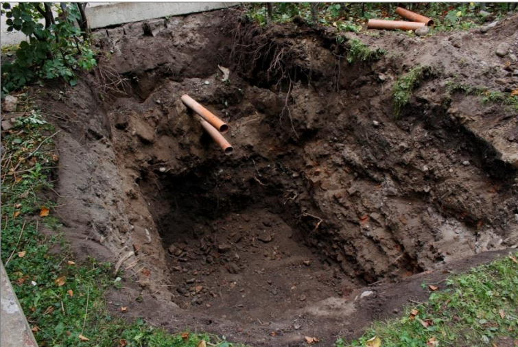
Figur 68. Det färdiggrävda Schakt H. Schaktet grävdes ca 3,1 m djupt. Foto mot Ö.
