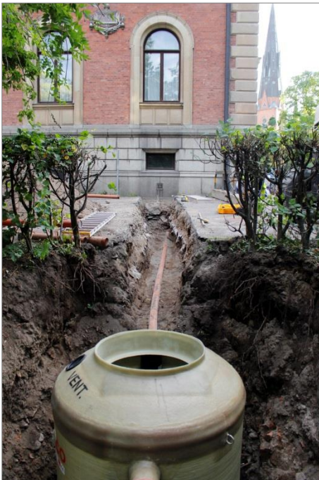
Figur 69. Schakt H med den nya fettavskiljaren och den nya ledningen monterade. Foto mot NÖ.
