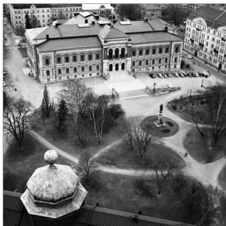
Figur 3. Universitetshuset och Universitetsparken i Uppsala är idag byggnadsminnesmärkta och förvaltas av Statens Fastighetsverk. Foto från domkyrkans torn av Torbjörn Ehrnvall 1961. Foto TE0479, Upplandsmuseet.
