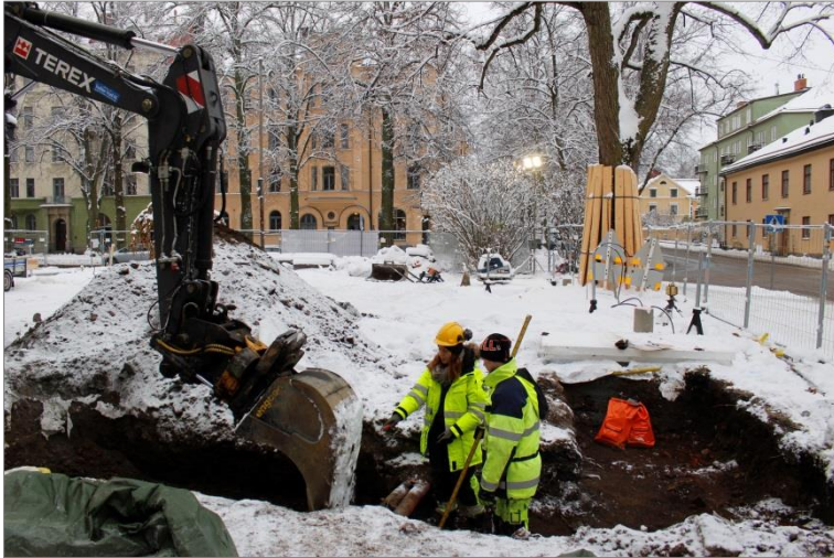
Figur 57. Pågående schaktning av etapp 2 i Schakt G. Foto mot SV.
