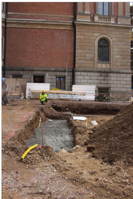
Figur 49. Översikt över Schakt C som grävdes vinkelrätt mot Schakt B. Foto mot SÖ.
