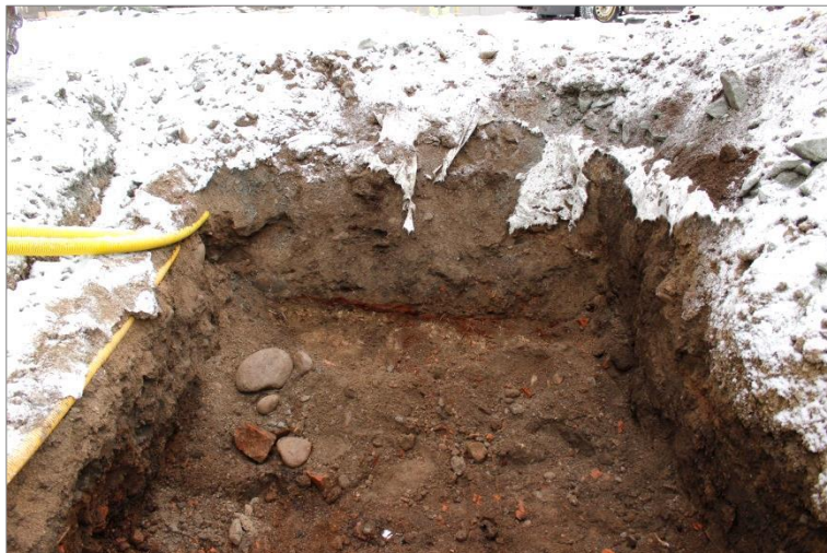
Figur 64. I den sydöstra schaktkanten fanns mot schaktets botten en horisontellt liggande träplanka, A13. Foto mot SÖ.
