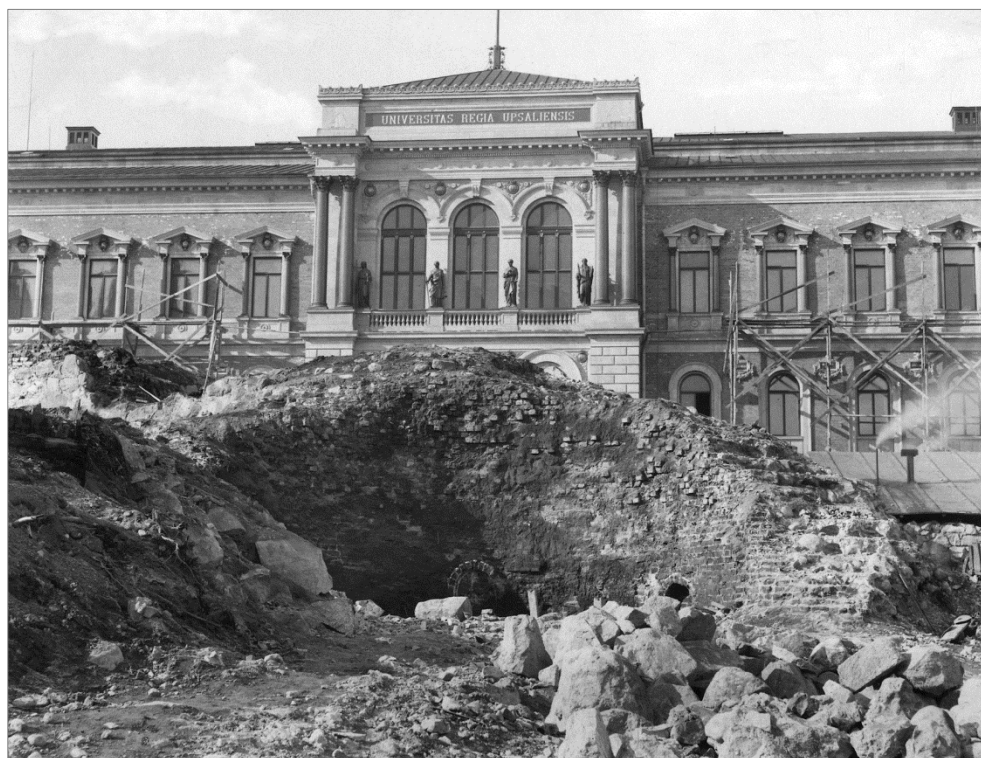
Figur 21. Ärkebiskopsborgens norra torn, Rundeln, låg fram till anläggandet av Universitetsparken som en över mark stående ruin. Rundeln har också gett namn till den intilliggande Rundelsgränd. Tornet var 17,5 m i diam. med 4,5 m tjocka skalmurar i tegel lagt i vendiskt förband med fyllning av gråsten. Tornet som också bar smeknamnet Styrbiskop byggdes sannolikt av Gustav Vasa. Fotot är taget 1886 då Universitetshuset var så gott som färdigbyggt. Fotograf okänd (Uppsala universitetsbibliotek).
