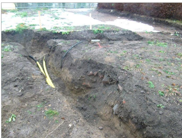
Figur 16. I schaktets östra del fanns ett raseringslager bestående av tegelkross och större tegelbitar. Foto mot V.
