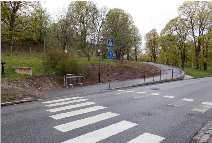
Figur 22. Den östra nedfarten efter avslutat arbete. Foto mot V.
