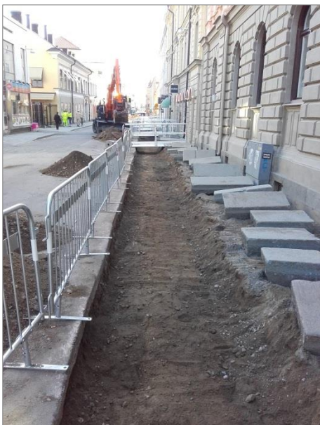
Figur 18. Schakt 6 grävdes i Drottninggatan för omläggning av gat- och kantsten. Foto mot NÖ.
