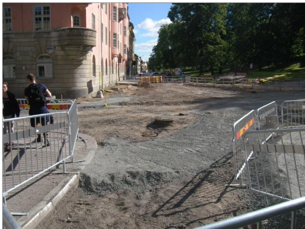
Figur 17. I korsningen Drottninggatan-Nedre Slottsgatan schaktades asfalt, kantsten och bärlager bort inför omläggning av dessa. Foto mot SÖ.
