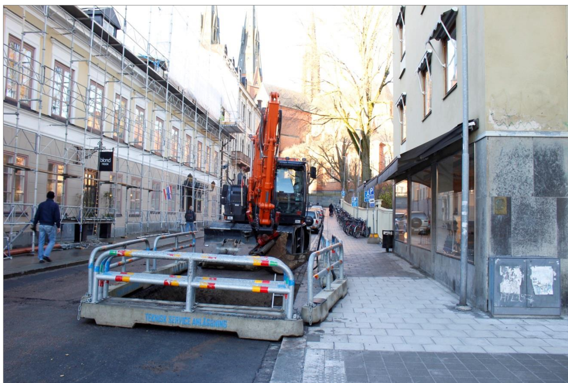
Figur 3. Pågående schaktningsarbeten i Trädgårdsgatan 2016. Foto mot N.
