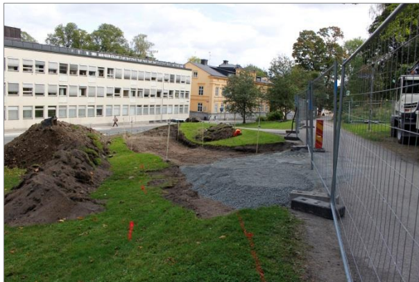
Figur 10. Schakt 3 grävdes parallellt med den befintliga gång- och cykelvägen för en ny sträckning av denna. Foto mot Ö.
