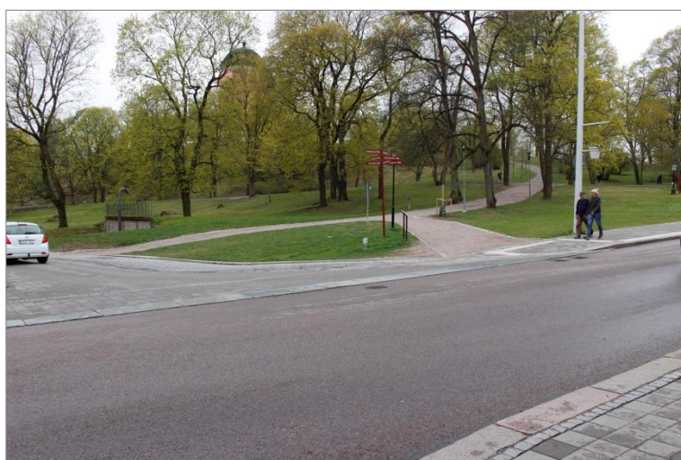
Figur 20. Den norra nedfarten efter avslutat arbete. Foto mot S.
