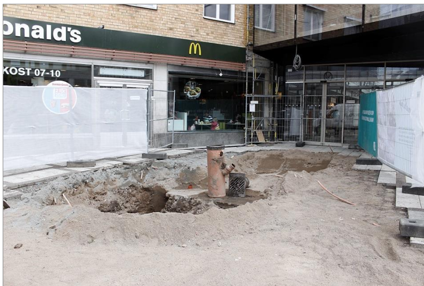
Figur 10. Schakt 1 grävdes på Forumtorgets östra del. Den nya dagvattenbrunnen placerades intill en befintlig brunn och stora delar av schaktet utgjordes av omrörda massor. Foto mot SÖ.
