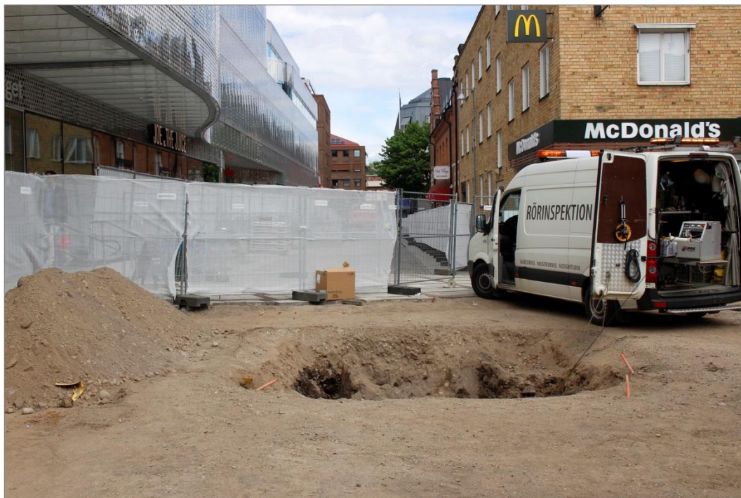
Figur 12. Schakt 2 förlades centralt på Forumtorgets norra del. Foto mot NÖ.
