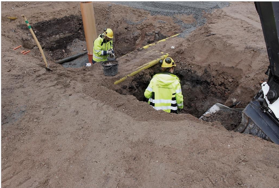
Figur 16. Anna Ölund, t.v., dokumenterar schakt 2 och Emelie Sunding, t.h., undersöker schakt 3. Foto mot N.
