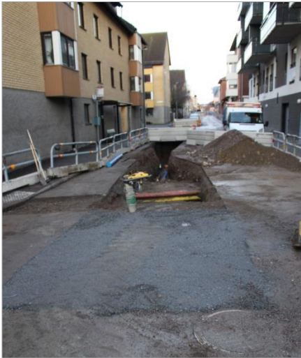
Figur 4. Schakt i Källgatan i riktning mot Stora torget. Foto Joakim Kjellberg, Upplandsmuseet.
