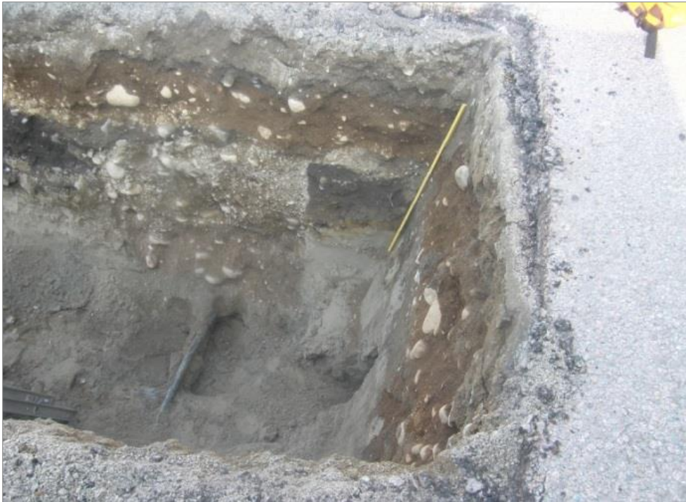
Figur 8. I schakt 5 syns exempel på de olika typer av ledningar som kunde förekomma i schaktet. Vattenledningen ligger direkt under den tvärgående, mindre ledningen. Bevarat äldre lager syns invid tumstocken. Foto mot VNV, Malin Lucas, Upplandsmuseet.
