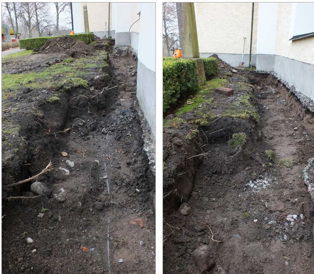
Figur 18, t.v. Schaktet på norra sidan av långhuset, vid tornet. Belysningskabeln låg längsmed hela schaktet. Foto mot Ö, Elin Säll, Upplandsmuseet.
